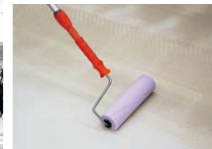
Schon die Grundierung erfolgt angenehm per Rolle im Stehen
